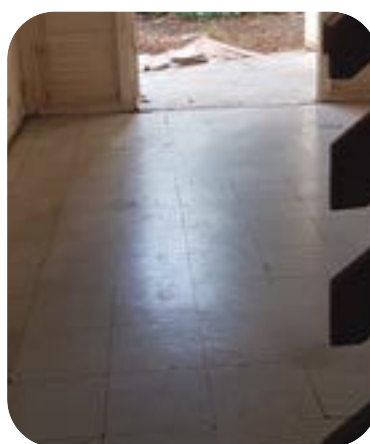
Avant/Après - Retrait de dalles vinyle et colle amiantées
