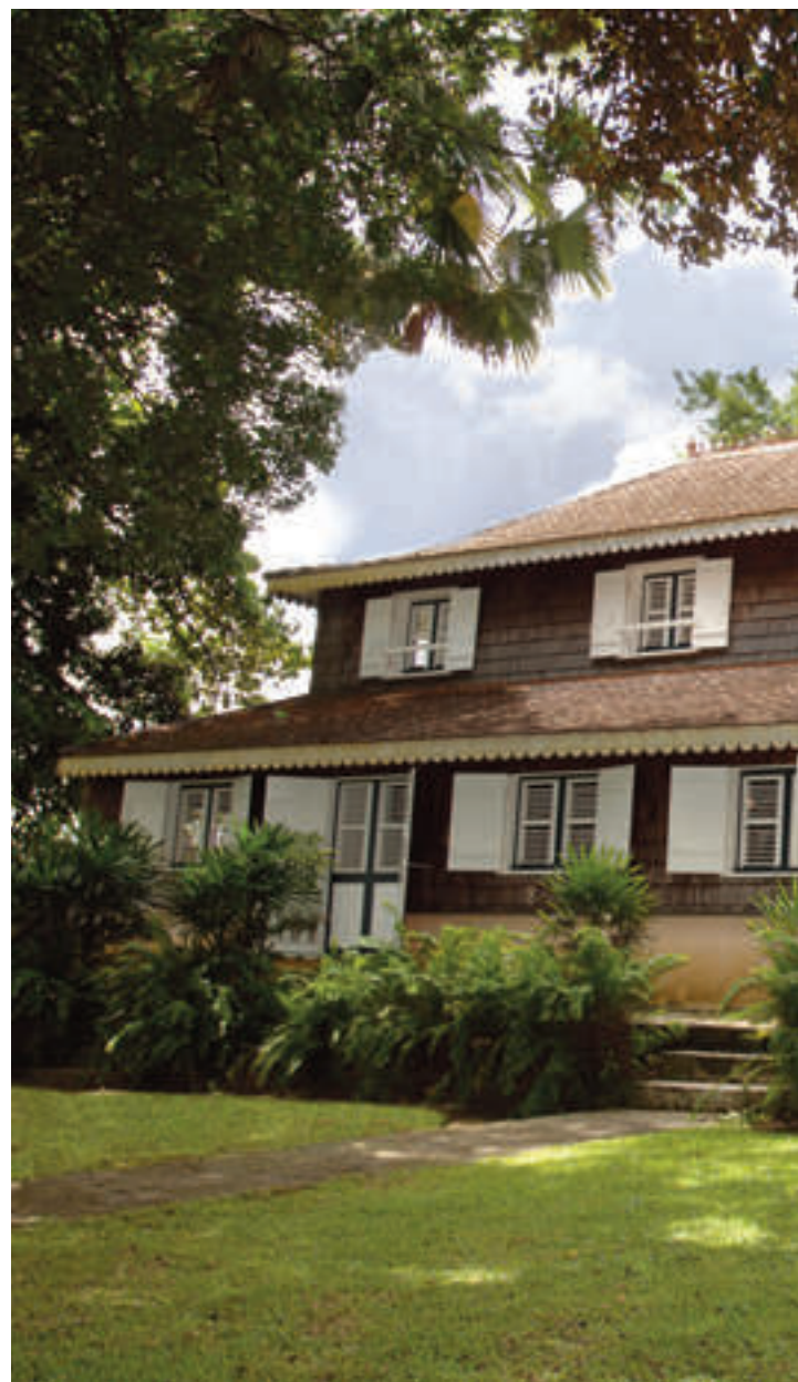
➤ Façade arrière de la maison
