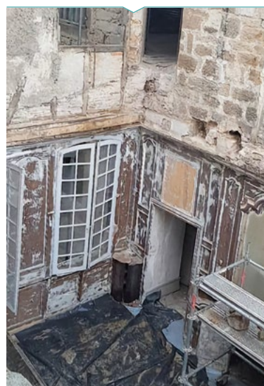
Projet en chantier © SCI 10 rue de Clermont
