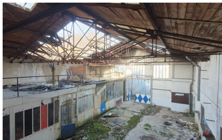
Visite à Poitiers le 12 décembre dernier sur le site Promenade des Cours propriété du bailleur EKIDOM afin d'identifier les possibilités de traitement d'un bâti à l'abandon pour réaliser des logements aux typologies variées sur une parcelle contrainte.
