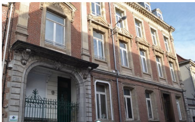
Résidence St-Julien avant la rénovation © Norvéie
