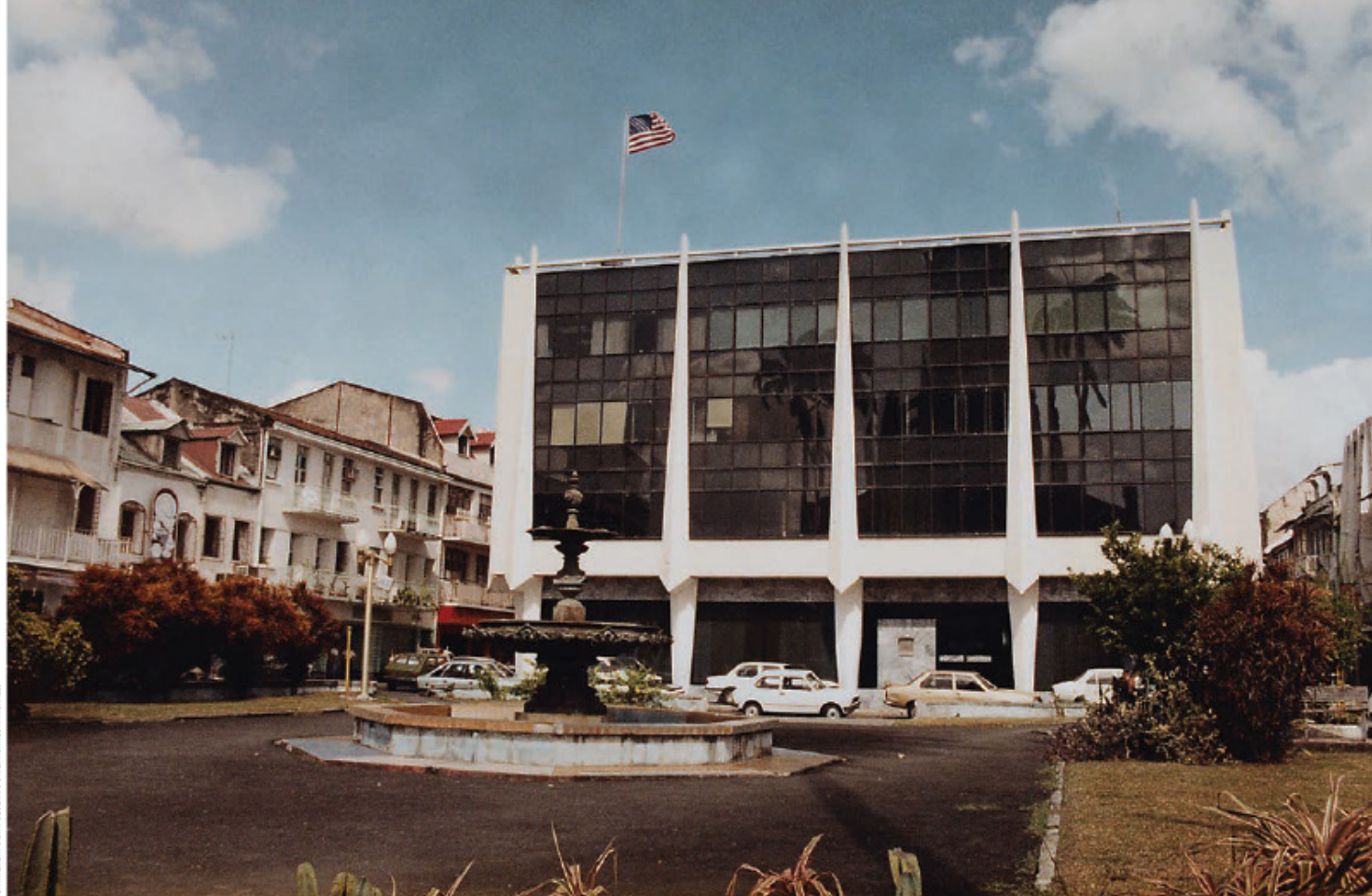
L'immeuble du consulat américain à Fort-de-France en 1983. Ce bâtiment, qui existe encore aujourd'hui, est situé en face de la cathédrale Saint-Louis.
