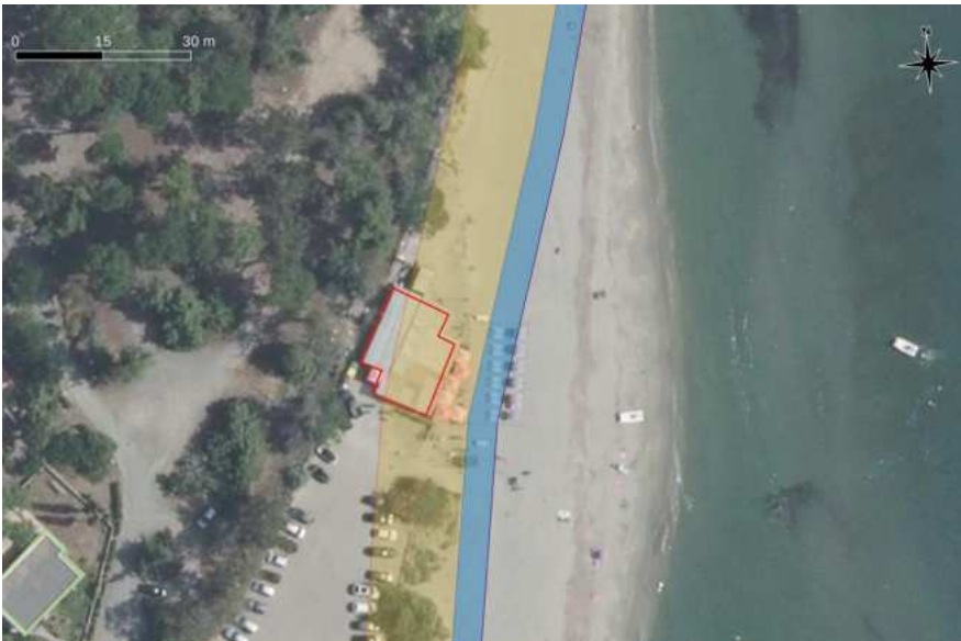
Figure 6 : Accrétion importante visible sur une orthophotographie récente au niveau d'une plage de Corse (Venzolasca), alors qu'une tendance érosive marquée était enregistrée par l'indicateur national sur une période d'observation différente. Le bâtiment en rouge, initialement pris en compte par le tampon, a été retiré de la pré-identification (fond de plan : Bd-Ortho IGN)
